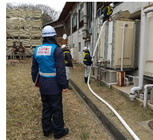
【給水班】能登町 給水状況（5日）
