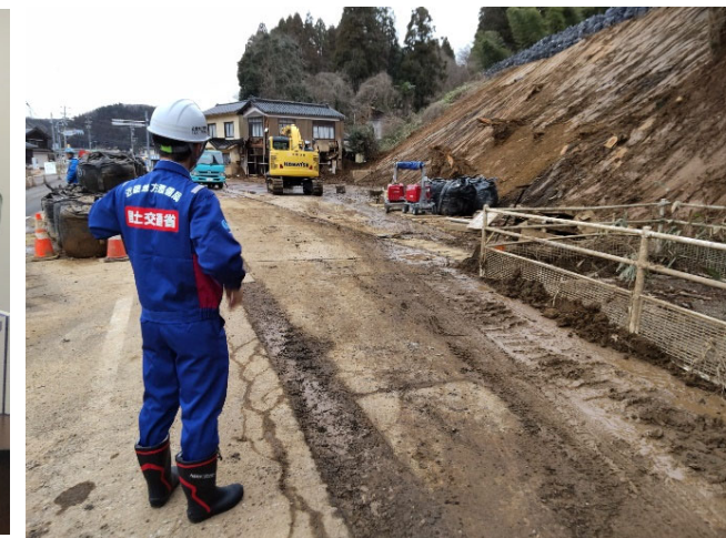
【水道班】穴水町 調査状況（5日）
