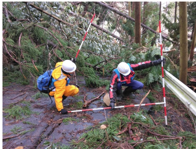
【道路班】輪島市 被災状況調査（10日）
