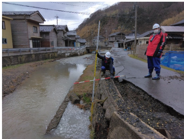
【道路班】輪島市 被災状況調査（23日）
