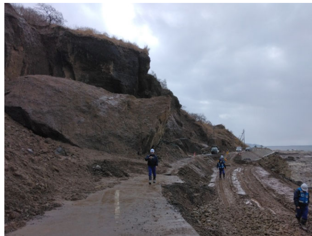
【道路班】輪島市 被災状況調査（23日）
