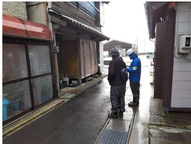
【営繕班】能登町 作業状況（15日）
