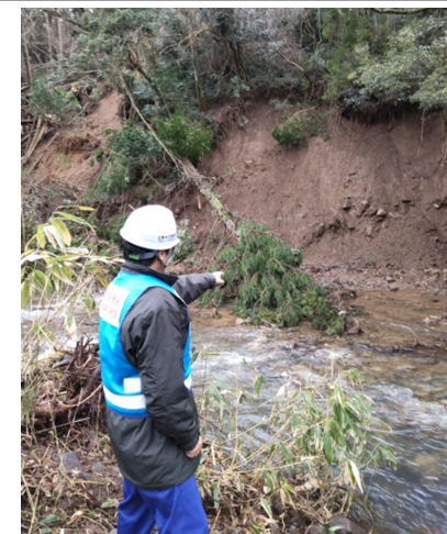
【砂防班】珠洲市 作業状況（20日）
