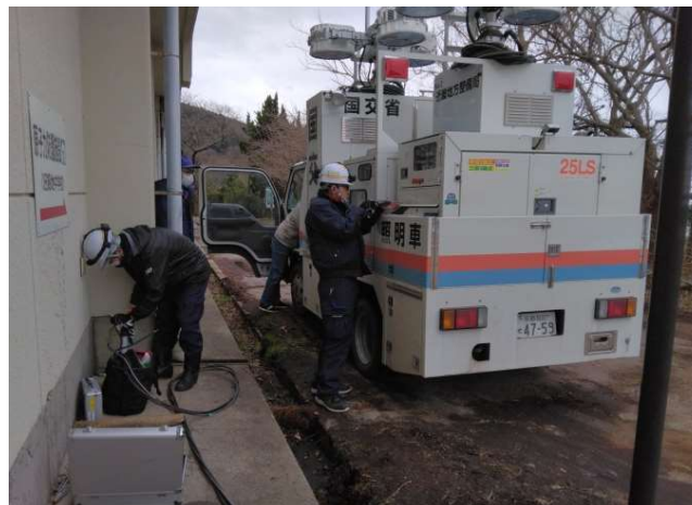
【電源支援班】輪島市他 作業状況（20日）
