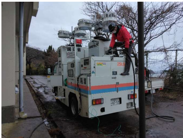
【電源支援班】輪島市、珠洲市他 作業状況(21日)
