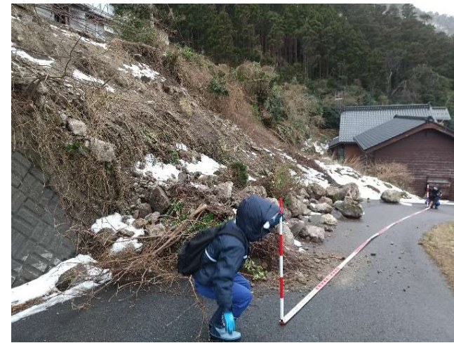
【市町道調査班】珠洲市 作業状況（26日）
