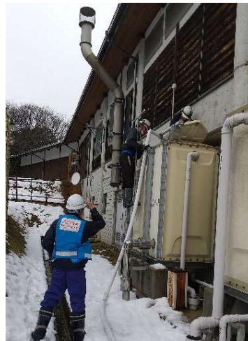
【給水班】能登町 作業状況（26日）
