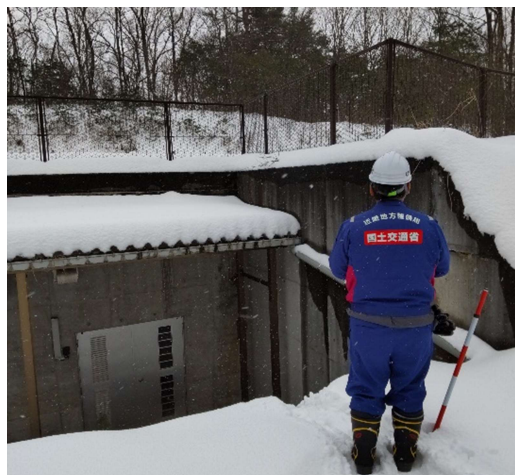
【水道班】穴水町 作業状況（26日）
