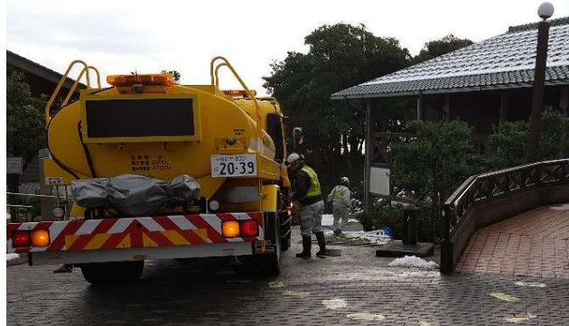
【給水班】能登町 作業状況（28日）
