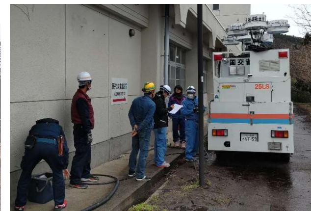
【電源支援班】輪島市 作業状況（28日）
