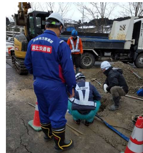
【水道班】穴水町 作業状況（28日）
