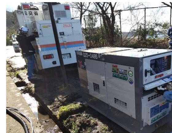
【電源支援班】輪島市 作業状況（29日）
