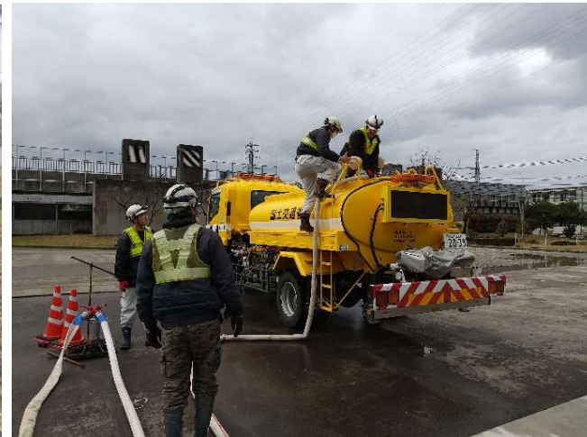
【給水班】金沢市 作業状況（8日）
