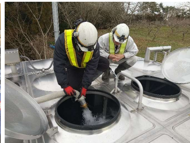
【給水班】能登町 給水状況（19日）
