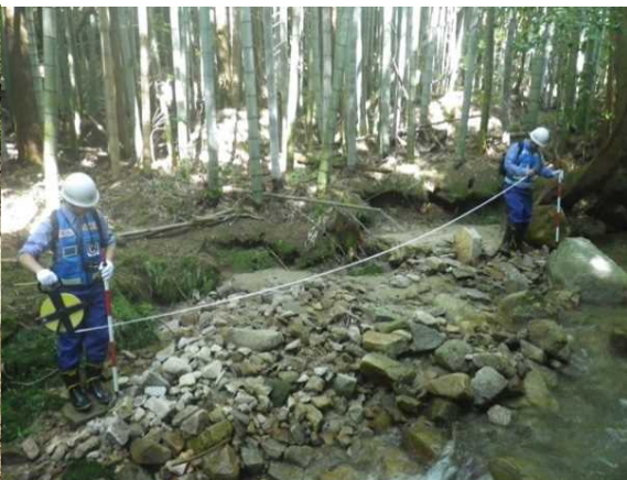
7/14 護岸洗掘状況調査
