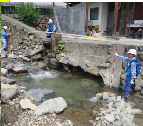
7/18 護岸洗掘状況調査
