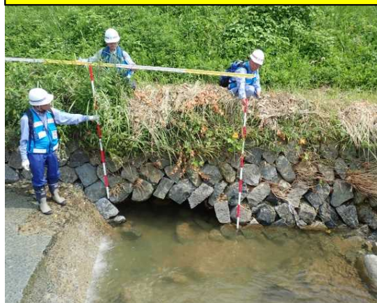
7/18 護岸洗掘状況調査
