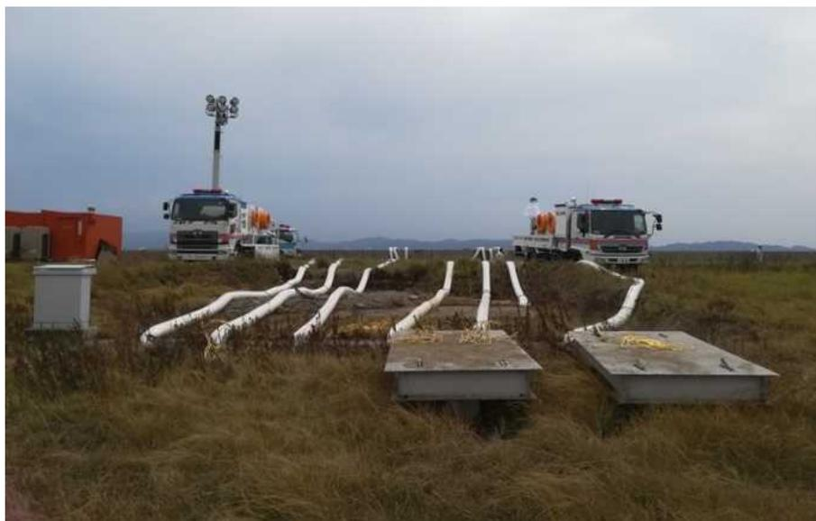
ポンプ車による排水作業(A滑走路)
