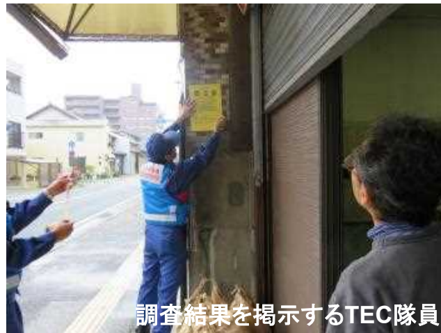
危険度判定の調査状況
