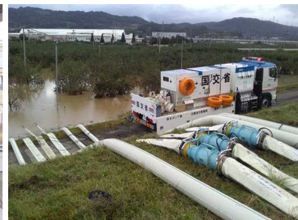
■10/15 排水作業状況（長野市小布施町地先）
