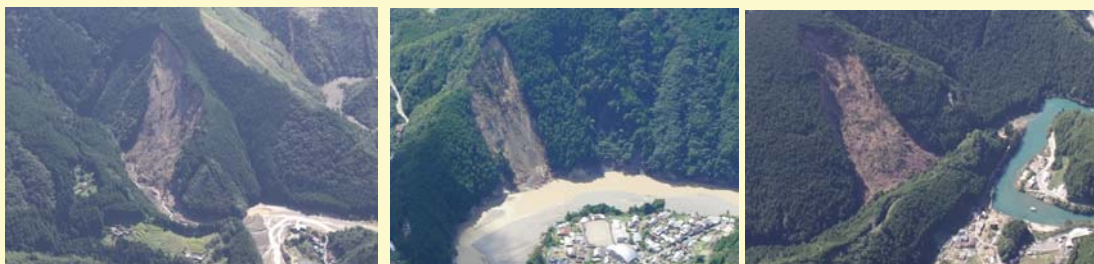
昨年の台風12号による被害箇所の復旧を推進します。(写真は左から十津川村五百瀬、十津川村折立、天川村坪内の被害箇所)
