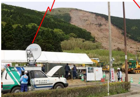
衛星通信車による 被災箇所の監視
