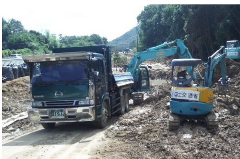
土砂の除去と道路啓開作業
