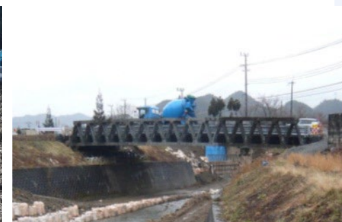
応急組立橋による交通路の確保
