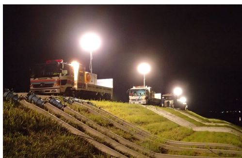
排水ポンプ車による緊急排水作業
