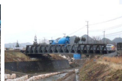
応急組立橋による交通路の確保
