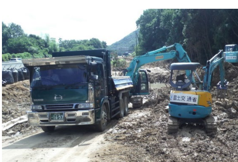
土砂の除去と道路啓開作業
