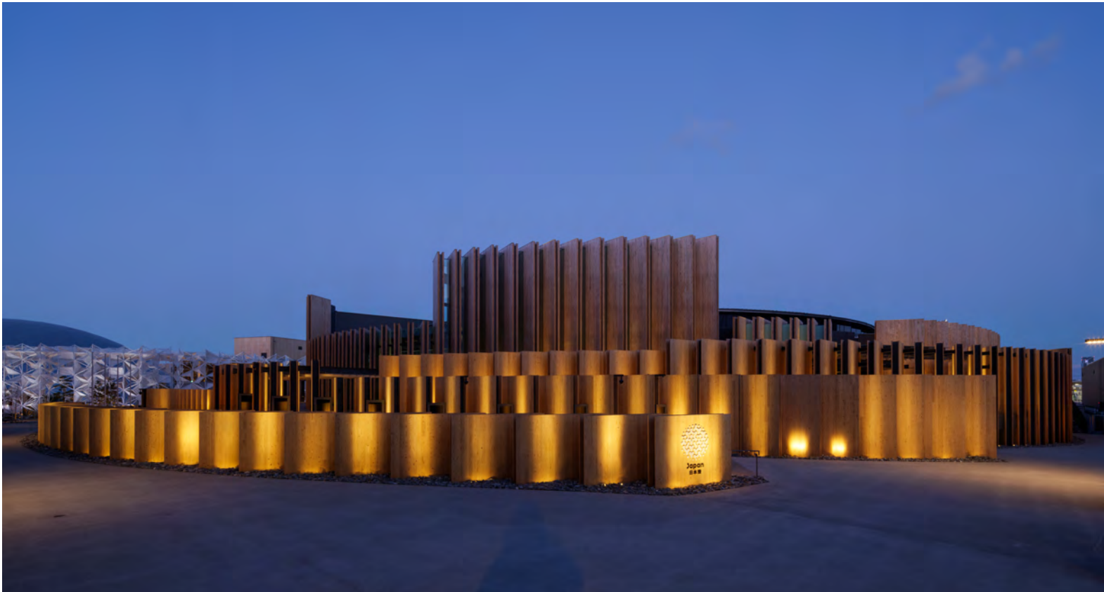
西側 正面外観 夕景
