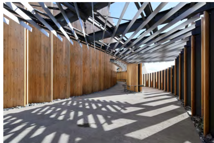
CLT に囲まれた屋外回廊
