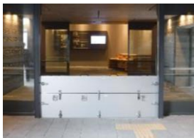
▲防潮板を使用した様子
