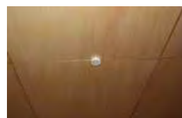
木製天井(合板貼り)
