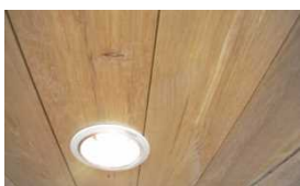
木製天井(板貼り)
