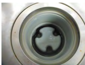
ワントラップ (流し台の排水などに設置)
