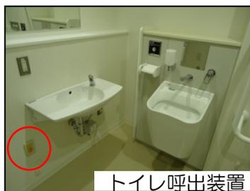
その他、よく目にする設備です。写真左上から、スピーカー、火災感知器、トイレ呼出装置です。スピーカーは、一般放送の他火災を知らせる非常放送を兼ねた物もあります。火災感知器は火災時発報し、ベルを鳴らして火災を知らせます。トイレ呼出装置は助けが必要なときボタンを押して（あるいは紐をひいて）信号を出します。
