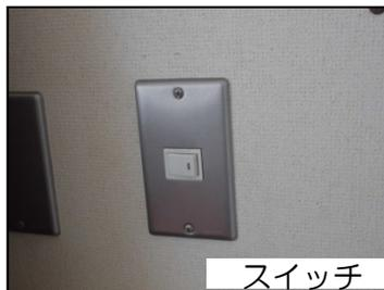
まず照明設備です。左上の写真から、照明器具、センサー、スイッチです。照明器具はLED照明器具が主流になっています。LEDの寿命は長く、電球の交換ではなく器具本体の取り替えになります。センサーは昼間の自然光の利用により、照明器具の照度を抑える明るさセンサーと、人が通ると照明が点灯する人感センサーがあります。スイッチは一般的なスイッチの他、複数の入り口から照明を点滅させる3路スイッチや、照明器具の点灯状態を知らせるためにスイッチに赤ランプや緑ランプを組み込んだものがあります。
