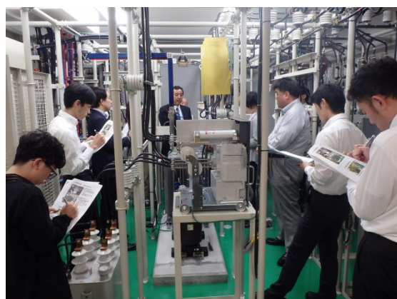
実習用受変電設備で内部機器説明
