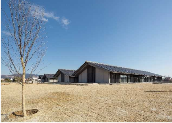
外観北西面（緑化）
