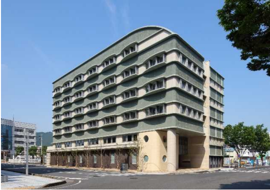
外観北東面（緑化）
