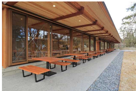
テラス（LED照明／木材利用）
