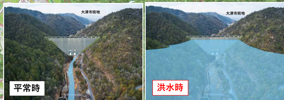
②ダム裏面（上流から下流方面）
