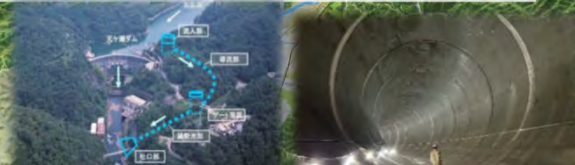
天ヶ瀬ダム再開発事業
