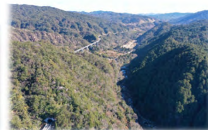
桐生辻トンネルから上流
