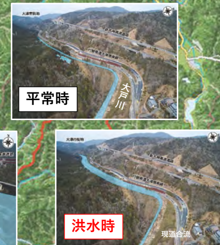
⑤ダム湖上流端（下流方面）
