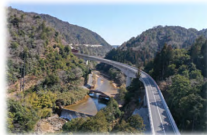
牧町天空大橋
