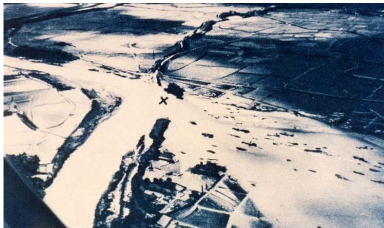
昭和28年9月(台風13号)による被害状況
