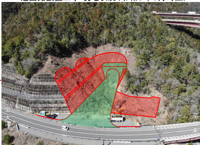
法面对策 現地状況(令和8年3月時点)
