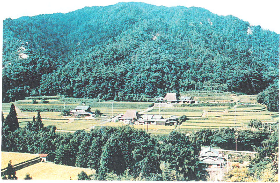
写真-3 大鳥居発電所水圧鉄管からの眺望
