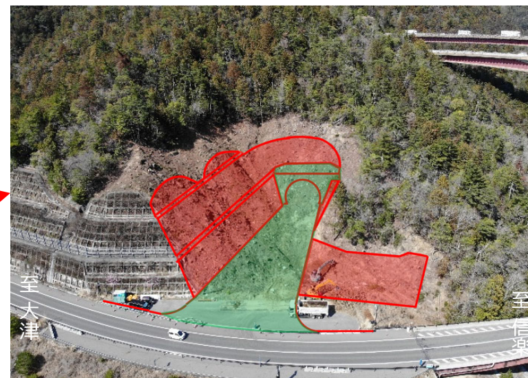
法面对策 現地状況(令和8年3月時点)
