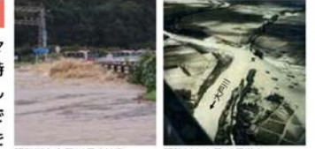
昭和57年台風10号の被害 石居橋の流出 昭和28年台風13号洪水 の羽栗橋下流(大津市橋)
