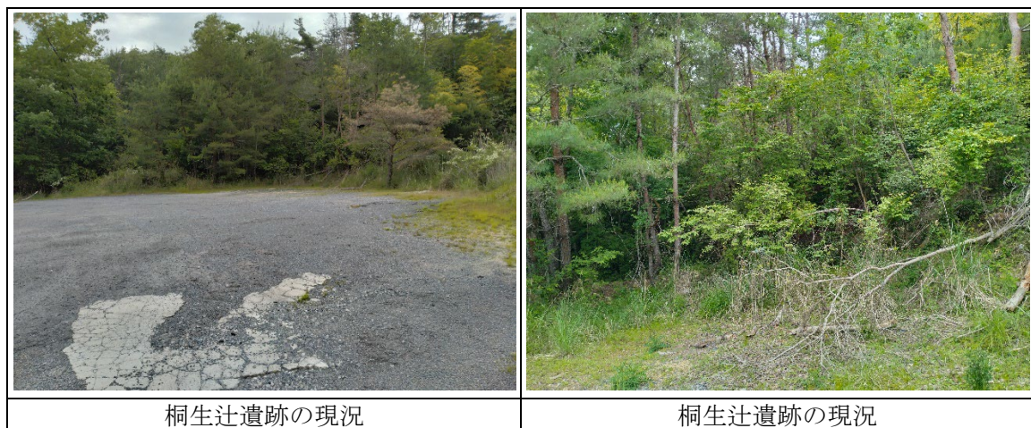
写真 5.1.12-2 桐生辻遺跡の状態
