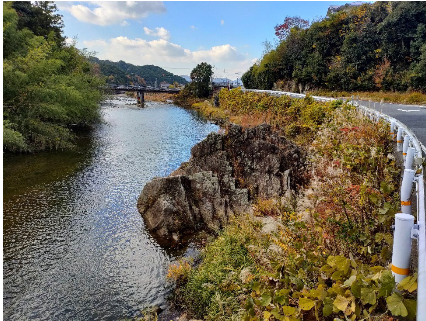
写真 5. 1. 13-3 千石岩の状況
