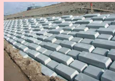
◀浸食に対する堤防補強例
