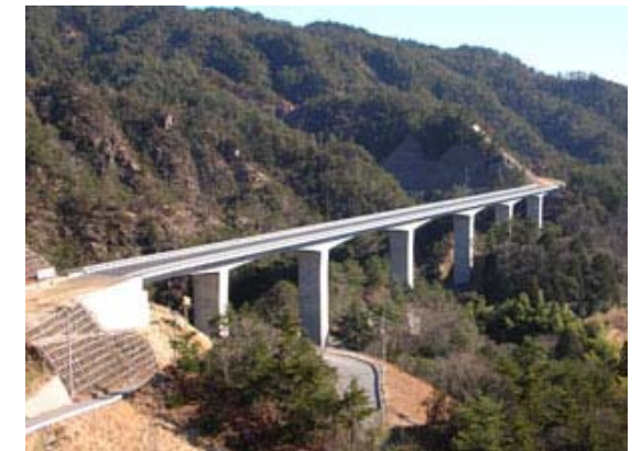
付替県道大津信楽線 2 4 号橋
