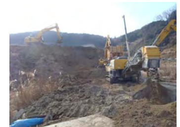
土質改良状況
