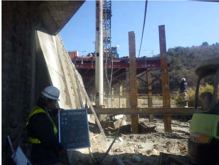
ダウンザホールハンマエ削孔状況
