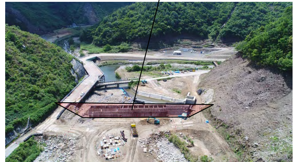
下流から上流仮締切工を望む
