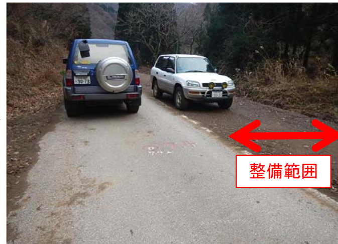
施工後(土工完了)
