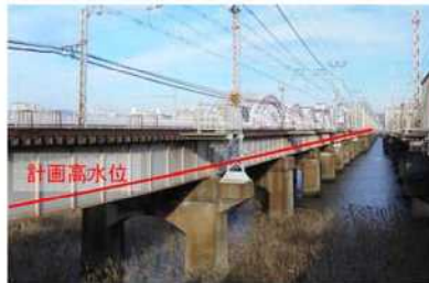
阪急神戸線淀川橋梁
