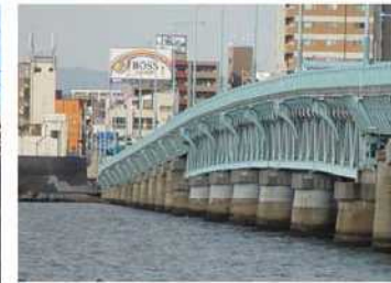
堤防に食い込む 国道2号淀川大橋
