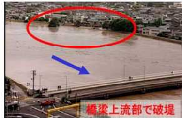
複数の橋梁で洪水が流れにくくなり水位が上昇(平成16年福井市:足羽川)
