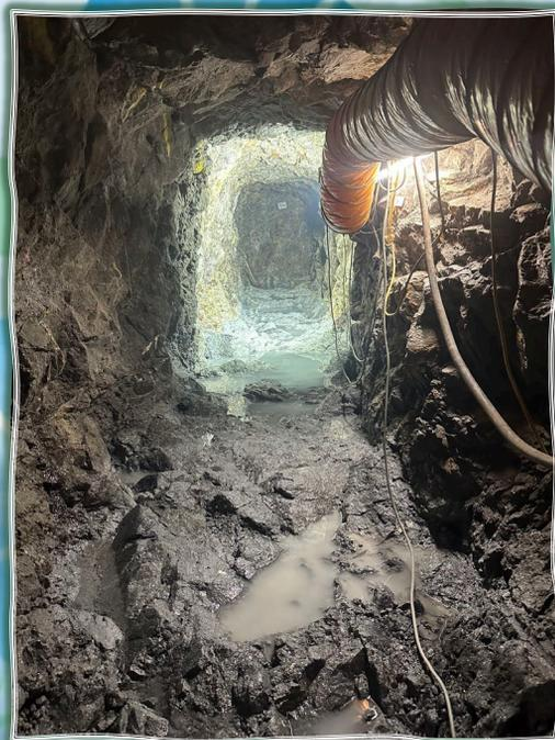
▲横坑掘削後、岩盤清掃（高圧の水などで余計な土砂などを除去し、調べたい岩盤を露出させる）した様子（他ダム）
