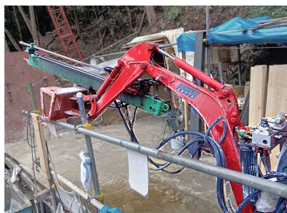
▲L-2坑で使用している重機 L-2坑は、油圧削岩機（「ドリルジャンボ」）などの重機を坑内に入れて掘削を進めています。
