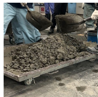
フレッシュ コンクリートの完成！
