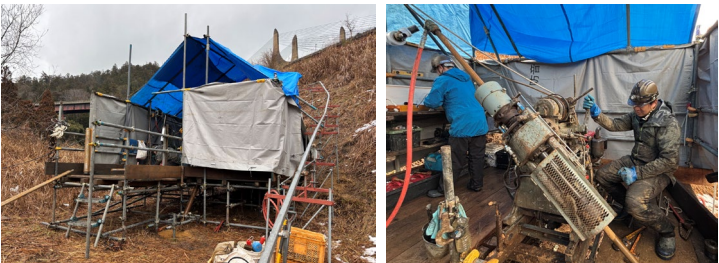
斜め方向のボーリング調査（設計⑩）
