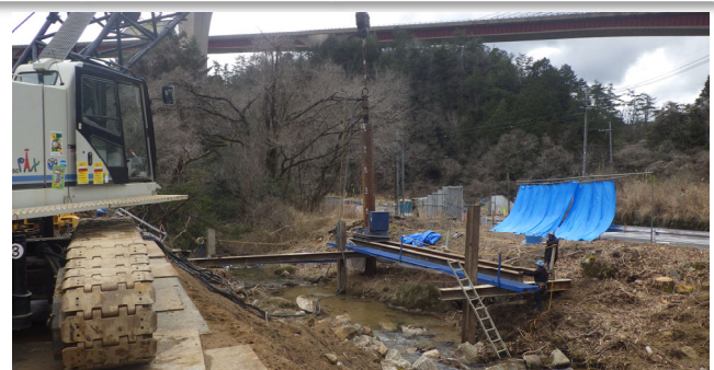
工事② 橋の杭を施工中
