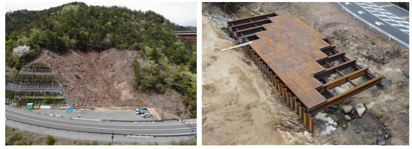
工事① 落石対策 工事② 仮橋完了
