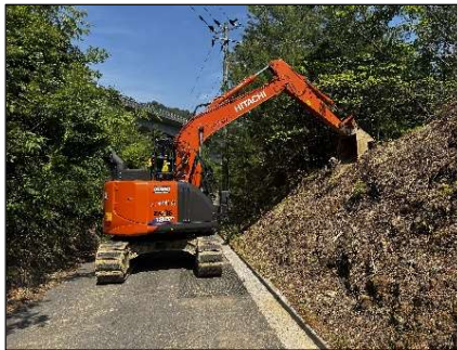
ICT建機 (マシンガイダンス) による掘削
