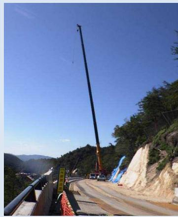
当初計画は、伐採に合わせて11号補強土壁を順次施工する事としていましたが、大型クレーン(220tクレーン)を使用して一度に広範囲の伐採を行う事で工期短縮が望めることから、計画変更を行い大型クレーンによる伐採を行いました。
