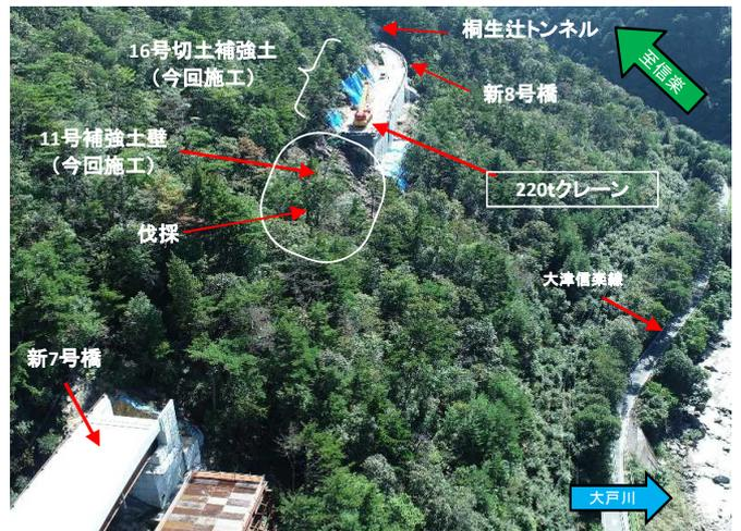
【現在の作業】220tクレーンにて11号補強土壁施工箇所の伐採を行っています。
