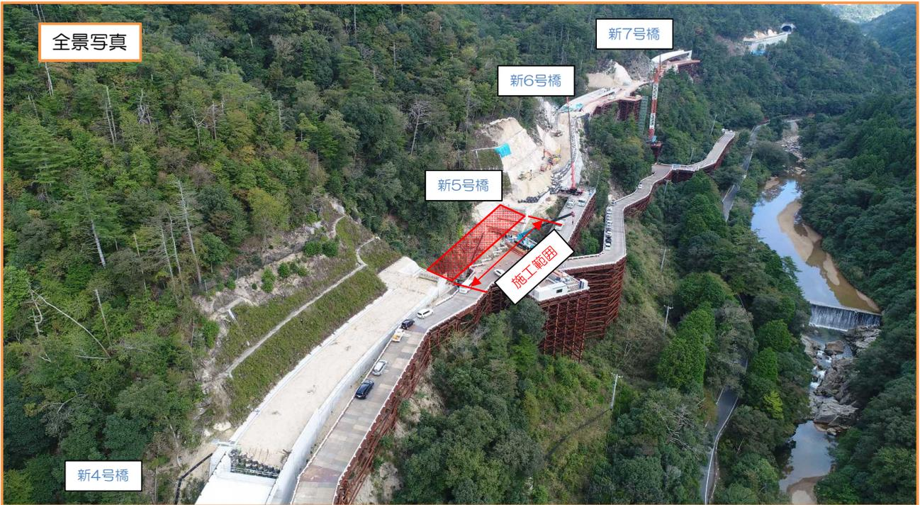
【現在の作業】 上部工架設準備として、「バント設備」の組立てや「支承」の据付等を行っています。
