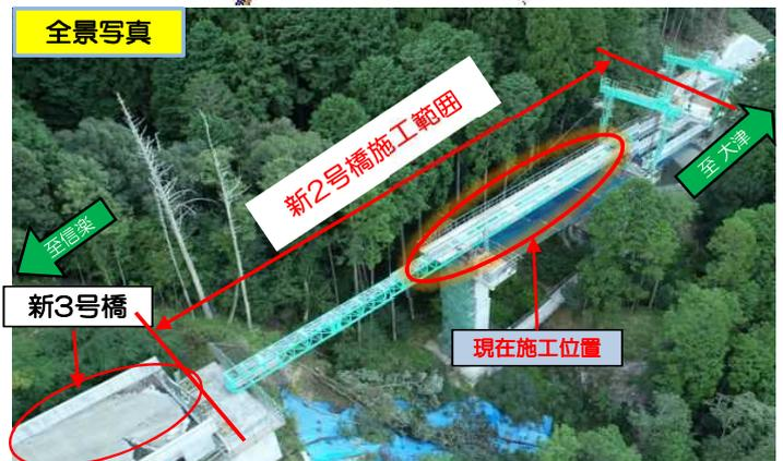
【現在の作業】 PC桁架設後、PC板の敷設を行い、架設桁を次径間(P1-P1)へ移動しています。
