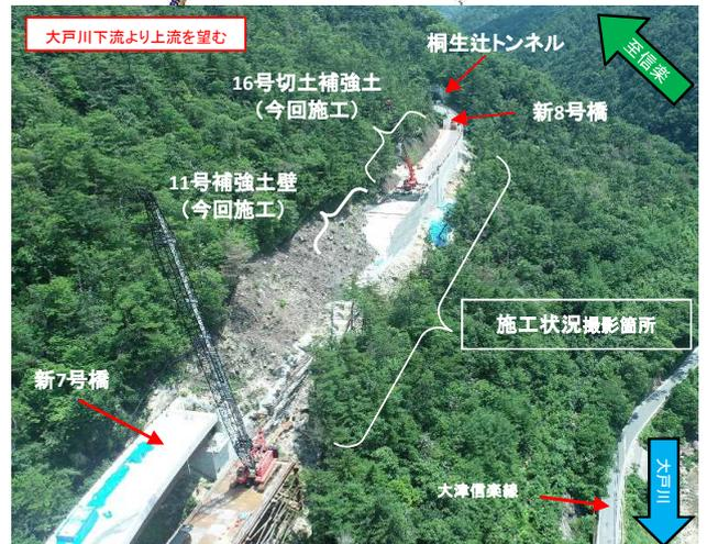
【現在の作業】 11号補強土壁擁壁部の軽量盛土材設置(今回施工部)が完了しました。
