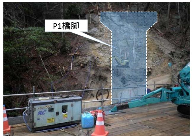
○1月16日現在 去年末に作業足場も完成し、年明けより、本格的に橋台躯体工に着手しました。コンクリートが凍結しないようにブルーシートで養生しています。
