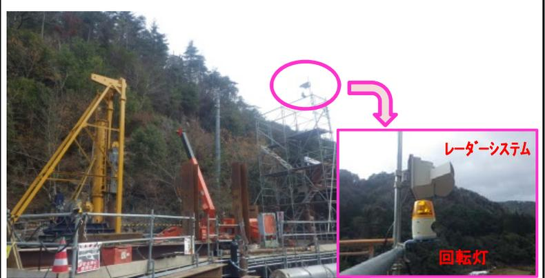
「レーダーシステム」を設置しています。クレーン等の作業時に、電線に対し、制限された高さを超えた場合に回転灯や音で警告します。
